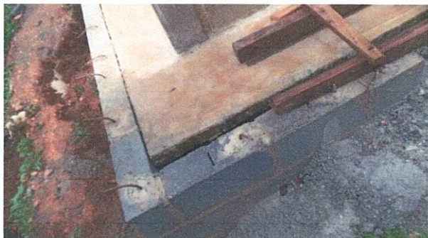
Foto1: Mejoramiento de muro perimetral a modulo.
