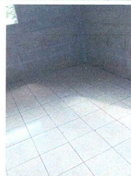
Foto 4: Mejoramiento de piso ceramico a modulo.
