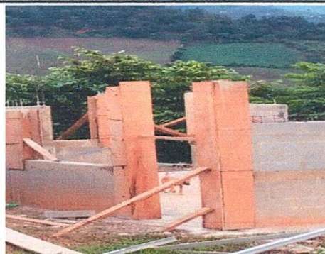
Foto 2: Mejoramiento de columnas sanitarias.
