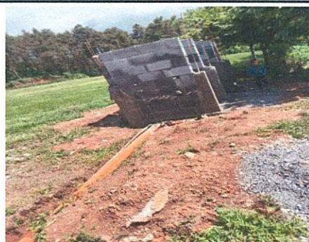
Foto 4: Mejoramiento de la tubería sanitaria.
