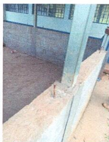
Foto 5: Mjoramiento de muros de modulo.
