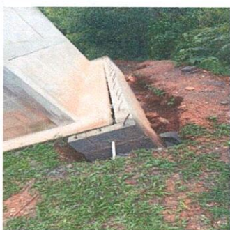
Foto 3: Mejoramiento de sanja a modulo.
