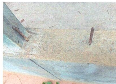
Foto 6: Mejoramiento de paredes de modulo.
