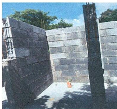
Foto1: Mejoramiento de paredes sanitarias.
