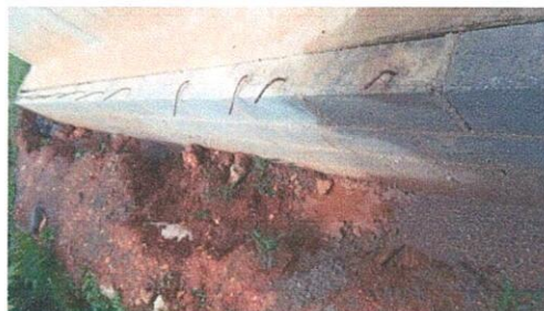
Foto 2: Mejoramiento de pared a modulo.
