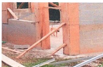
Foto 3: Mejoramiento de fundición de modulo.
