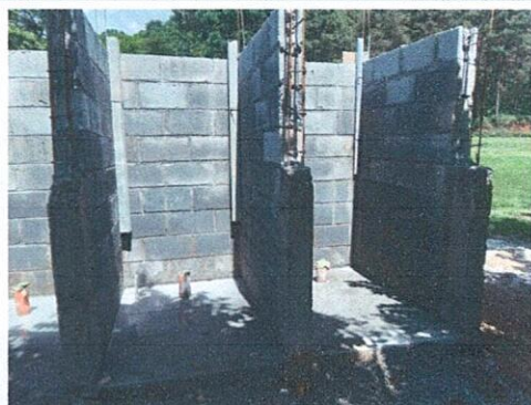
Foto 3: Mejoramiento de los espacios sanitarios.
